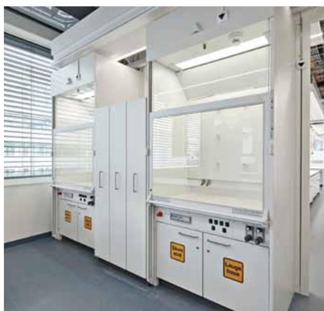
тем хуже удержание загрязнений внутри шкафа. На основе этих соображений в качестве доказательства соответствия стандарту DIN EN 14175 к статичному тестированию сопротивления добавлена обязательная динамическая составляющая. Рядом с вытяжным шкафом создается паразитный поток воздуха для стабилизации приточного потока, а также удерживающего потенциала вытяжного шкафа.
