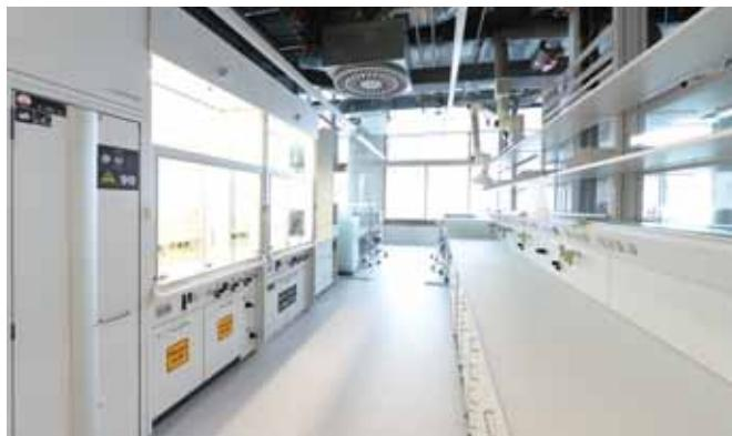
**Сервисные системы** – системы подвода коммуникаций и электричества – могут быть свободно стоящими, настенными или потолочными. Система каналов позволяет легко прокладывать кабели. Сервисные панели допускают практически неограниченное индивидуальное расположение всей арматуры и элементов.
